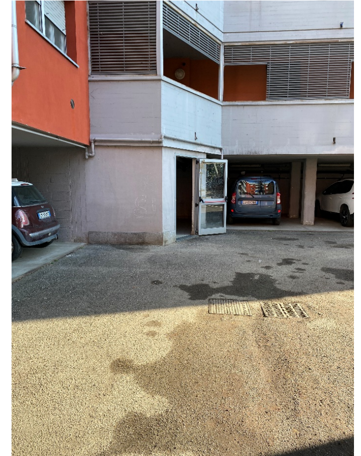
PORTA ACCESSO CORRIDOIO CANTINE - PORTA CON MANIGLIONE - RIF. N. 1
