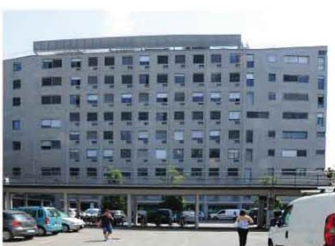
41 1982-1986 | Nave (arch. Gio Ponti)
