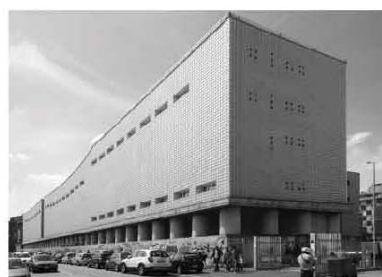
42 1996-1999 | Dipartimento di fisica e chimica (arch. Francesco Soro)
