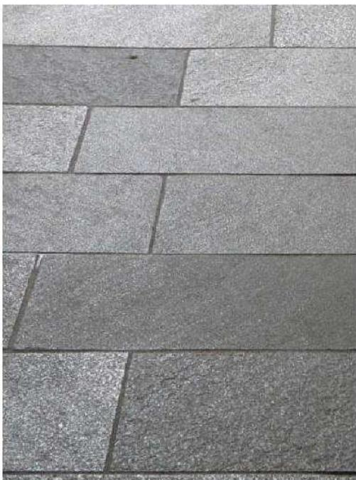
Pavimentazione in beola, in lastre a spacco naturale di cava di forma rettangolare, spessore 4 - 6 cm, dimensioni fino a 70 x 35 con coste rifilate di fresa.
