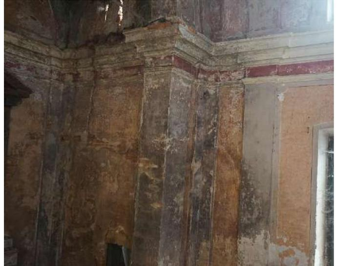
Figura 23 Degrado dell'intonaco dell'abside
