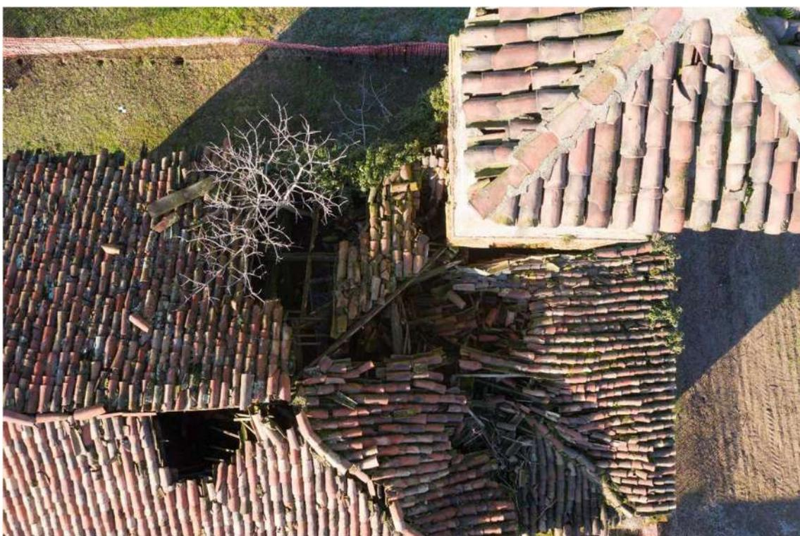
Figura 29: Particolare delle lacune della copertura, sono visibili i gravi ammaloramenti dell'orditura del tetto
