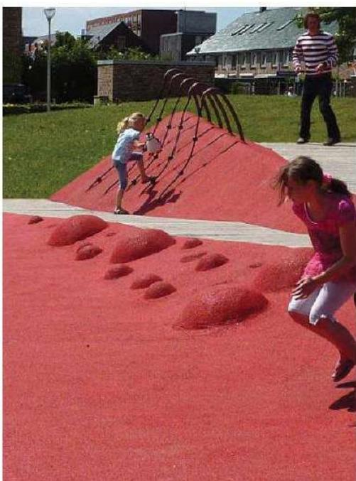
Pavimentazione antitrauma elastica, drenante, antiscivolo, atossica, resistente al fuoco conforme alla normativa UNI/EN 1177, dello spessore totale di 63 mm.
