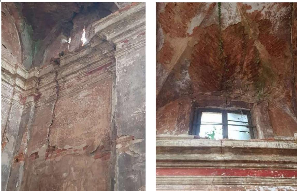
Figura 18: Esempi di gravi fessurazioni interessanti pareti e volta dell'edificio
