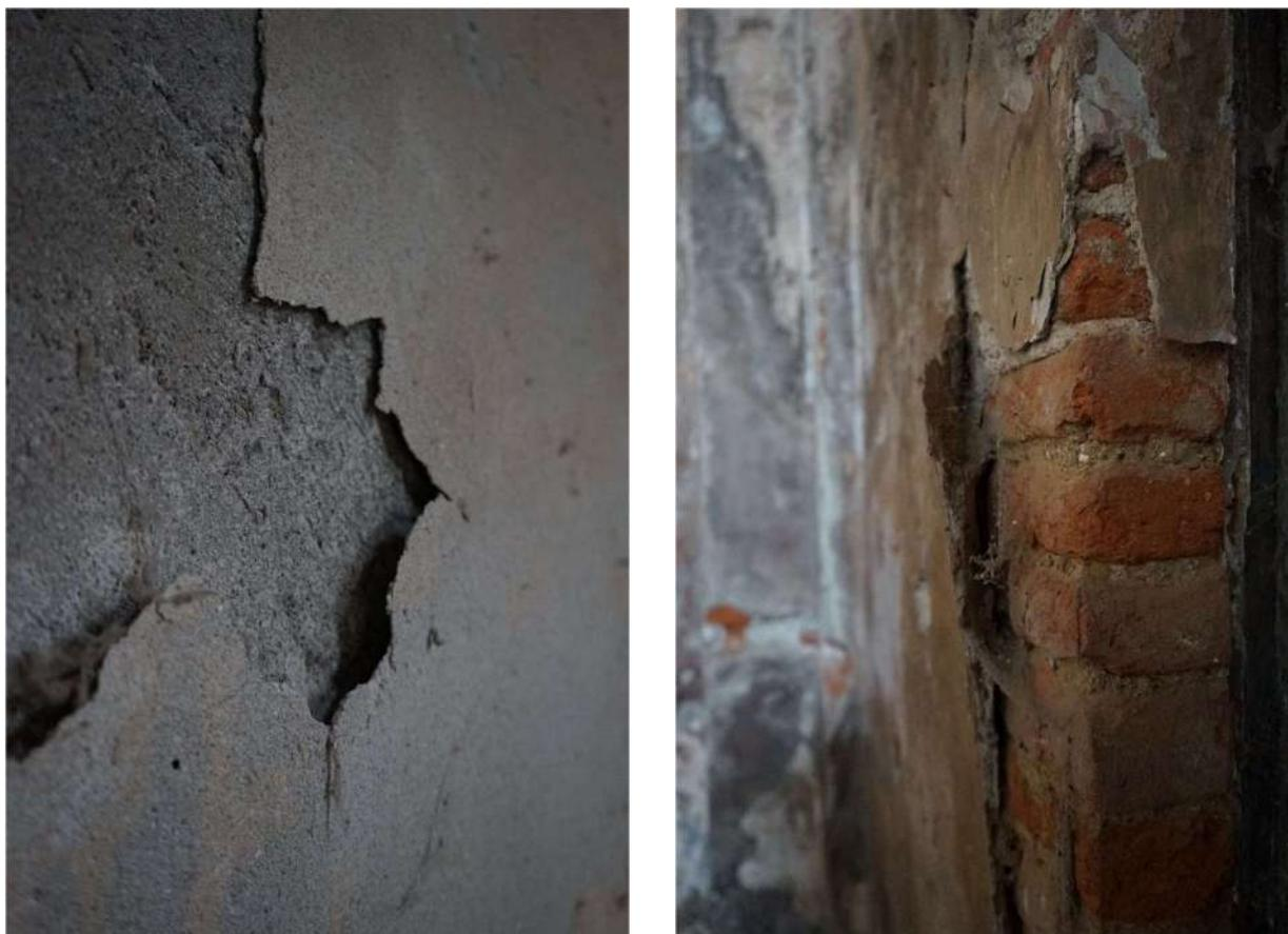
Figure 4-5: Esempi di notevoli distacchi dell'intonaco
