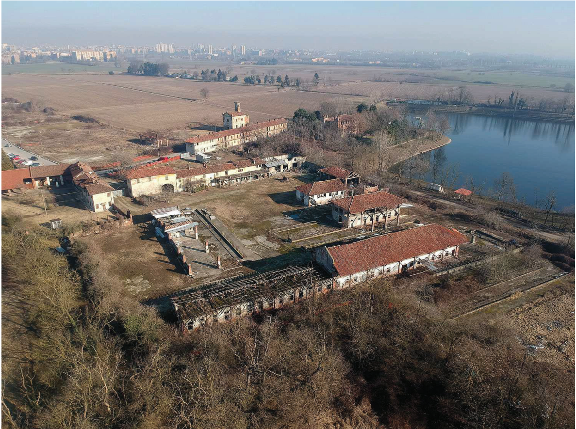
Vista sud: stato di fatto
