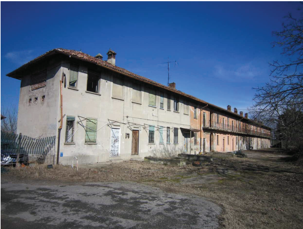
Vista interna edificio salariati
