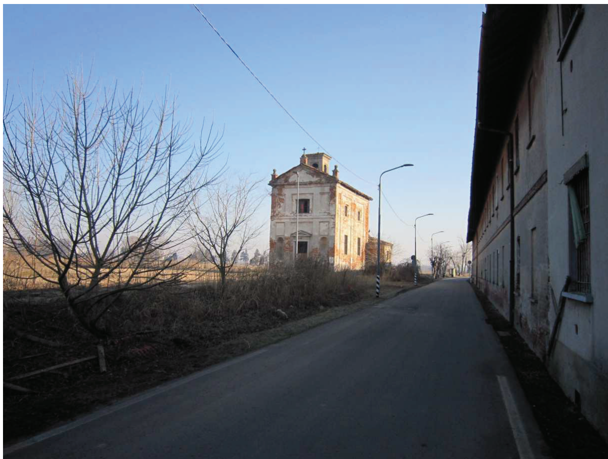
Vista dello stato di fatto di via Macconago
