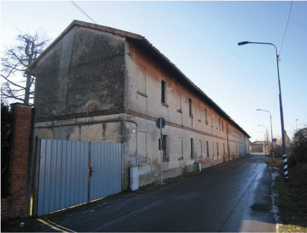
Vista esterna edificio salariati
