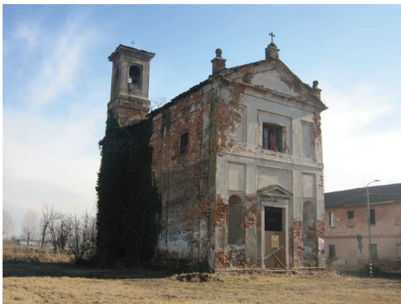
Particolare della facciata principale
